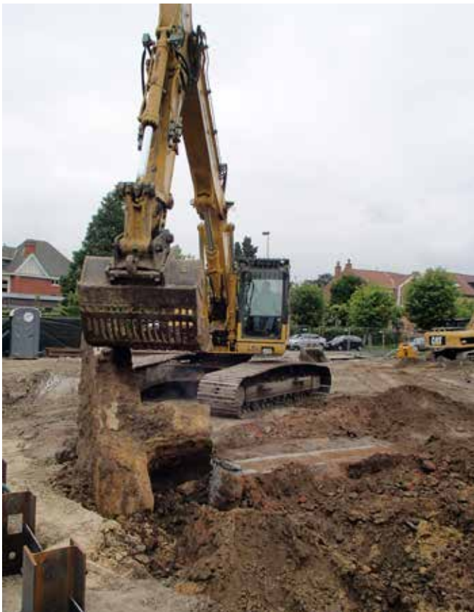
Figuur 5: De kraan graaft een bakstenen fundering uit
