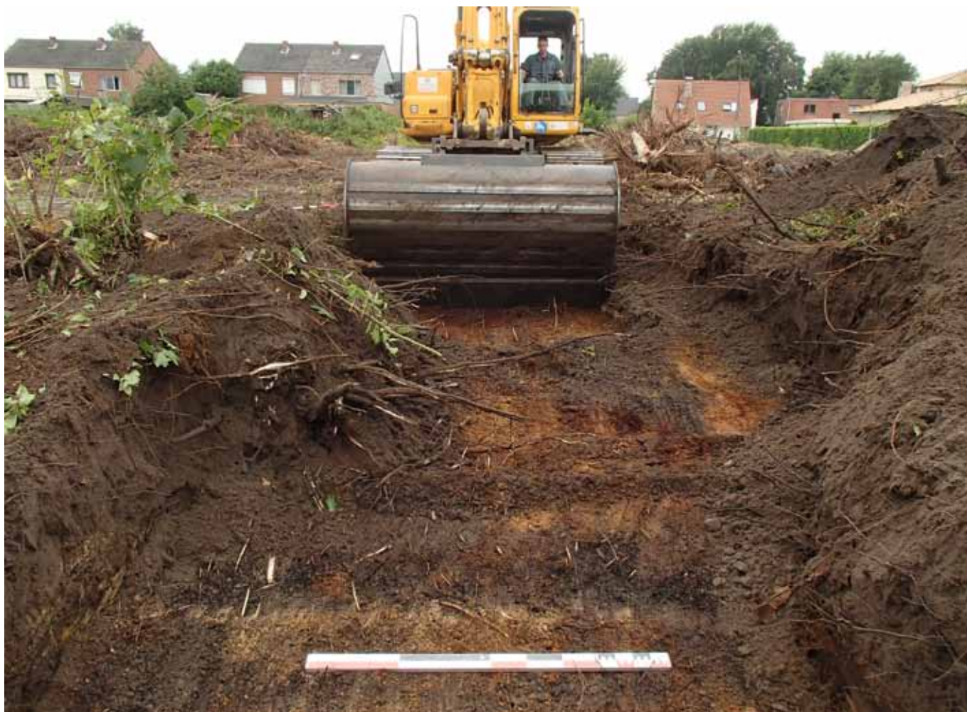
Figuur 8: Stevige wortelkluiten werden door de kraan plaatselijk omzeild
