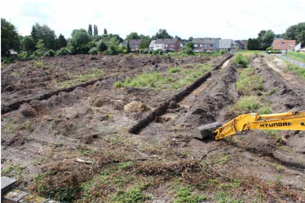
Figuur 5: Zicht op het projectgebied na het graven van de proefsleuven
