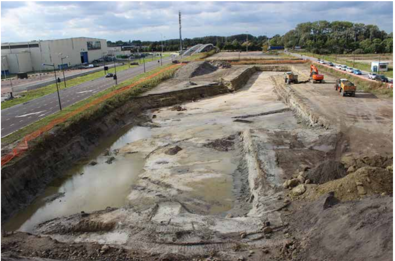
Figuur 6: Zicht op de aanleg van de werkput van de eerste fase van het onderzoek op veld 50
