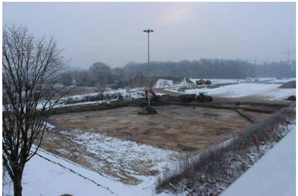
Figuur 5: De derde fase van het onderzoek had plaats gedurende de maanden januari en februari van 2013
