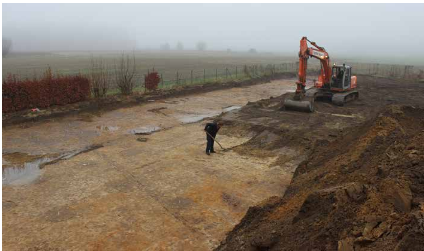
Figuur 4: Onder toezicht van de archeologen werd de teelaarde weg gegraven tot op het archeologisch niveau. De grondsporen werden tijdens het afgraven onmiddellijk manueel opgeschaafd
