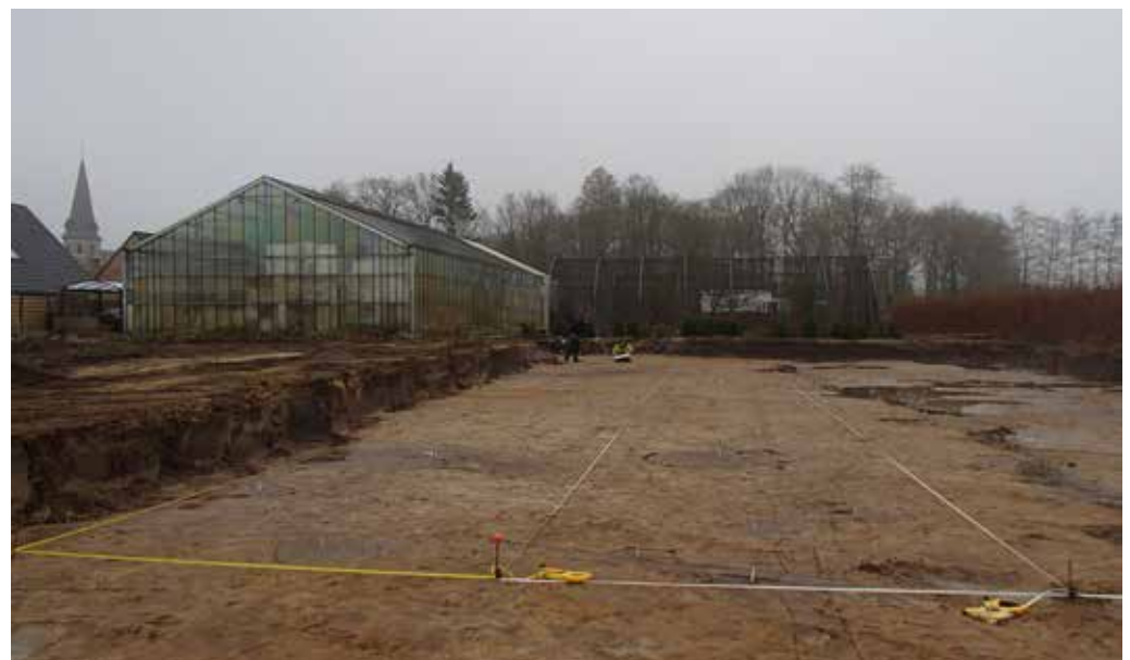
Figuur 36: Gebouw 14 (op de voorgrond) tijdens de werkzaamheden
