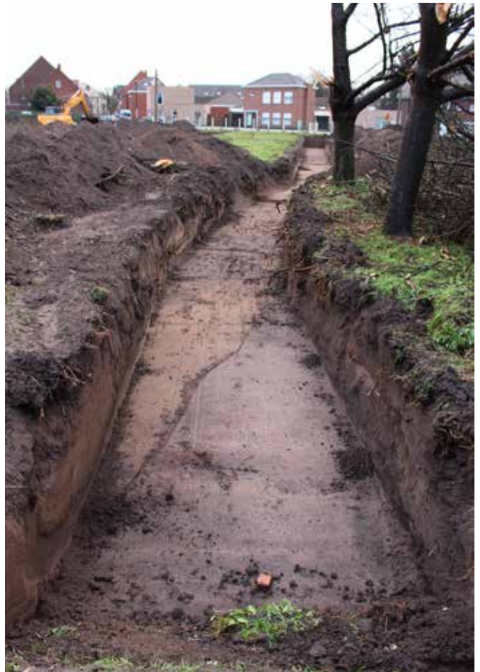
Figuur 27: Het westelijk deel van sleuf 03
