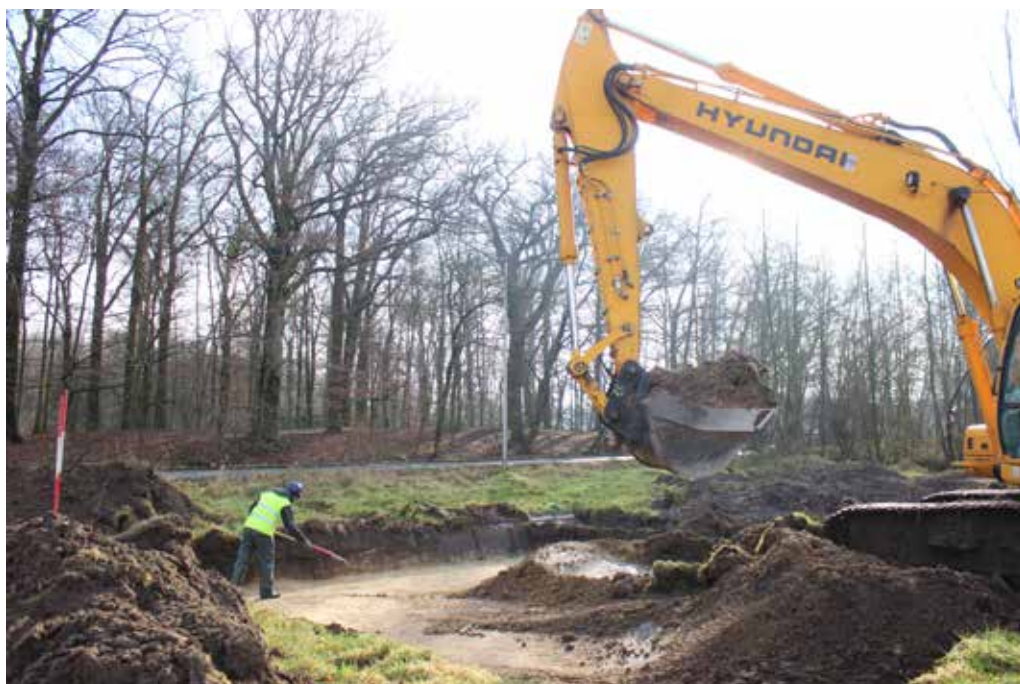
Figuur 6: Ook tijdens de aanleg van de kijkvensters werd de bodem opgeschaafd om eventuele sporen beter zichtbaar te maken
