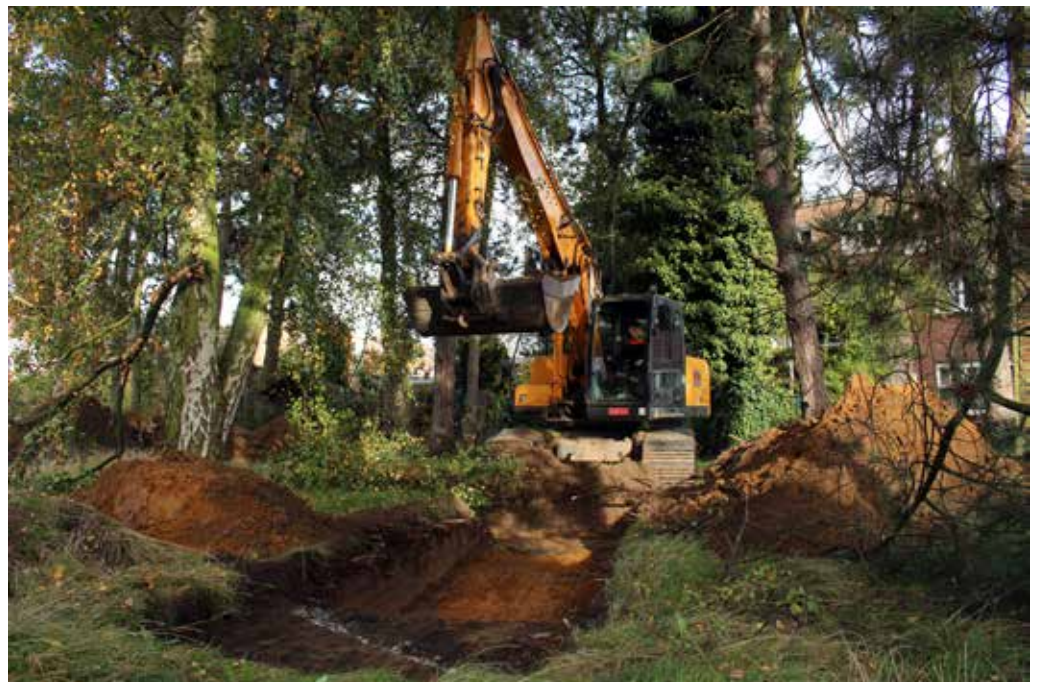
Figuur 7: Het aanleggen van proefsleuven was op sommige plaatsen moeilijk door de aanwezigheid van bomen
