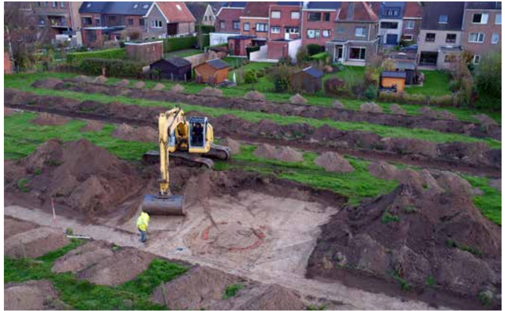
Figuur 41: Kijkvenster 19 met waterput 1313
