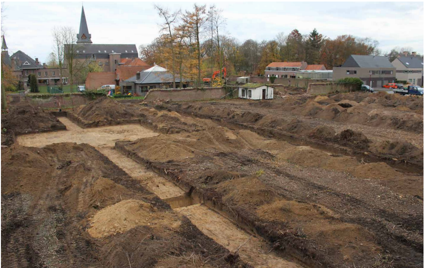
Figuur 59: Overzicht op het zuidoostelijk deel van het plangebied
