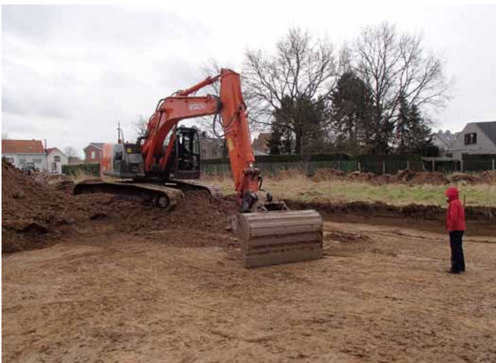
Figuur 5: Het aanleggen van een kijkvenster
